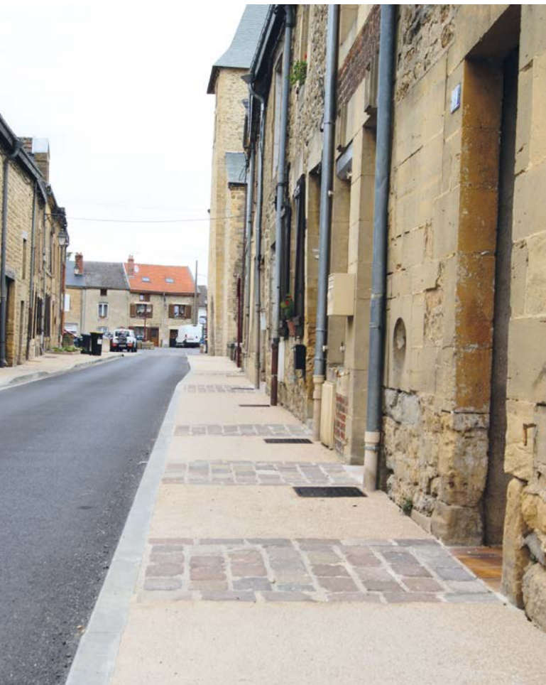
Les trois revêtements de la rue de la République : alternance entre le bitume noir de la chaussée, l'ocre du béton désactivé, et les pavés.
