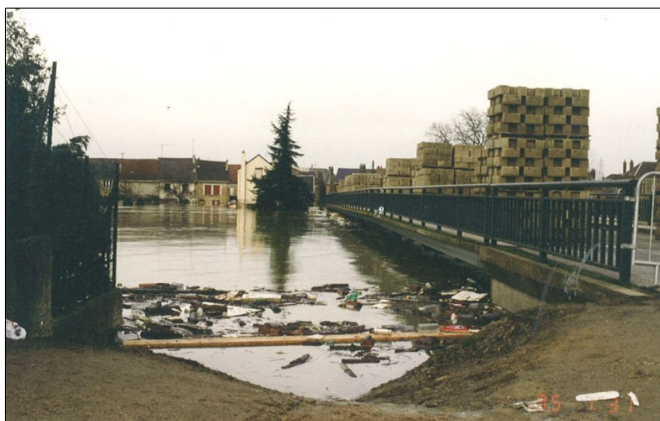
Tablier du pont de Warcq immergé, pont lesté et fermé à la circulation
