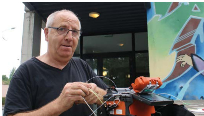
Un technicien d'Orange soude un brin de fibre optique © Philippe Henry pour Orange
